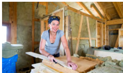
Beim Umbau der alten Konkordia-WC's
